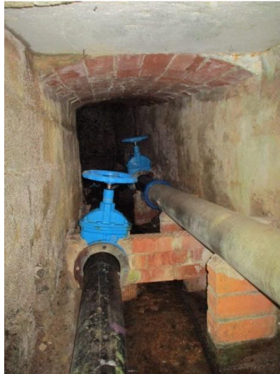
Il·lustració 12. Galeria captació Resclosa La Verneda
