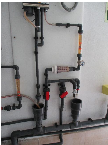
Il·lustració 21. ETAP La Verneda: sala de dosificació de reactiu i d'analitzadors en línia
