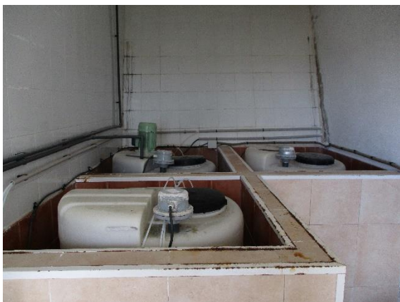
Il·lustració 26. ETAP Dipòsit Nou: mesuradors en línia i bombes dosificadores
