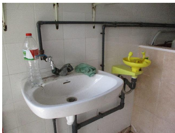
Il·lustració 27. ETAP Dipòsit Nou: sala d'emmagatzematge de reactius
