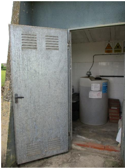
Il·lustració 17. Sobreelevació Ter: emmagatzematge i dosificació d'hipoclorit sòdic
